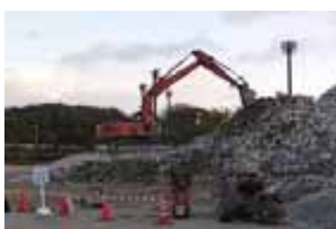
再資源化するコンクリート塊
