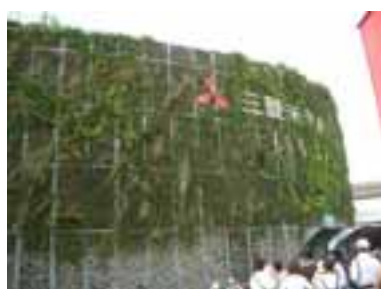
(*3) 岩と植栽による外壁
