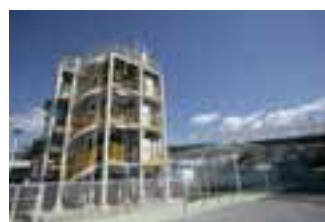
高温ガス化システム
