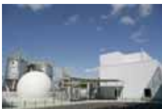
メタン発酵システム
