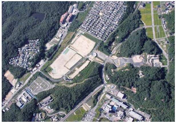
瀬戸会場（解体撤去工事後）
