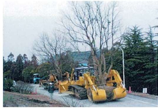
支障木の移植
