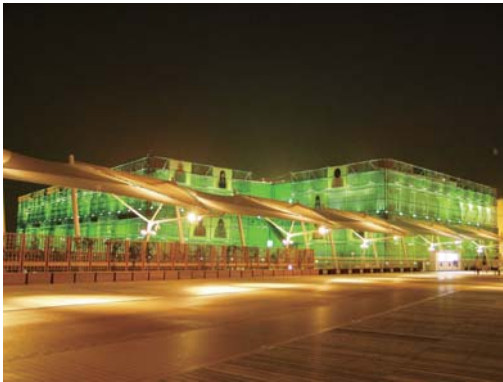
照明器具の設置方法等の工夫・配慮
