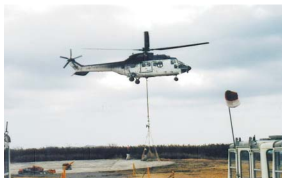
ヘリコプターによる作業風景
