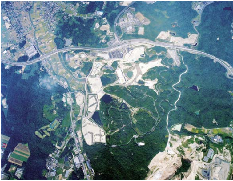
長久手会場（解体撤去工事後）
