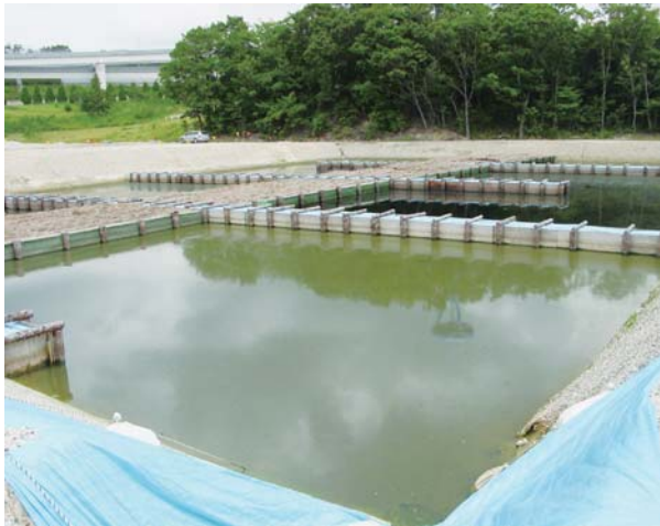
日立館跡地工事用沈砂池
