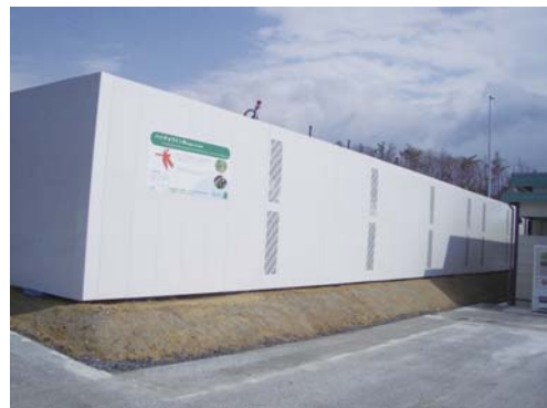
藤岡駐車場環境保全措置紹介パネル設置状況
