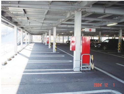
立体駐車場（左：1F アスファルト、右：2F 鉄板床材）
