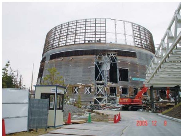
瀬戸会場（解体撤去工事中）
