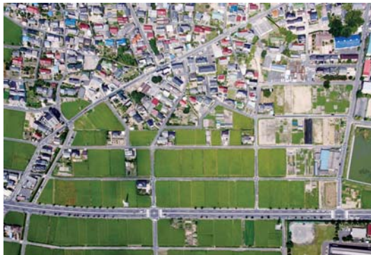
自家用車駐車場（尾張旭）（解体撤去工事後）
