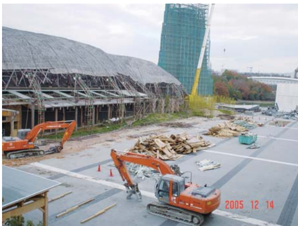
長久手会場（解体撤去工事中）
