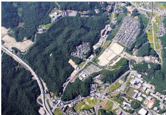
会場間ゴンドラ（解体撤去工事後）
