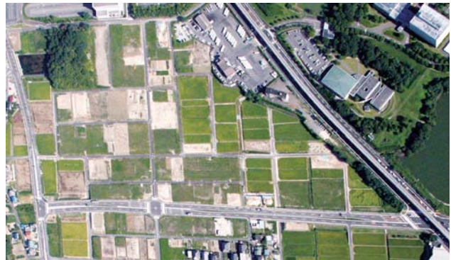
自家用車駐車場（長久手）（解体撤去工事後）
