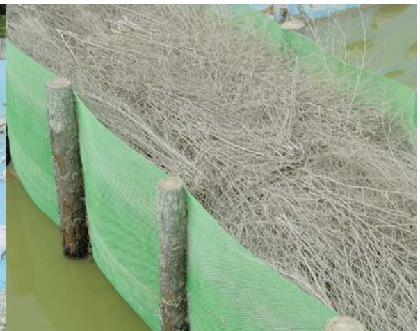
コモン5 アフリカ共同館跡地工事用沈砂池
